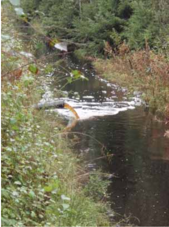
Ohitusputki saostusaltaasta vesistöön
